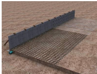
ขั้นตอนที่ 8 เมื่อลงวัสดุดินถมถึงระดับเสริมแรง ตามแบบก่อสร้าง ติดตั้งวัสดุเสริมแรงขั้นที่ 1
