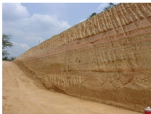
รูปที่ 5.16 การขุดปาดผนังด้าน Back Slope MSE Wall ให้เรียบก่อนปูวัสดุ Geotextile
