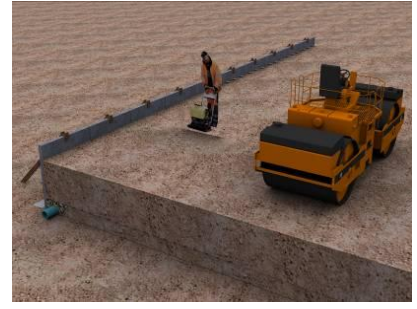
ขั้นตอนที่ 12 ลงวัสดุดินถมเสริมแรง และทำการบดอัดในชั้นต่อไป จนถึง ระดับใกล้ขอบบนของPanel ที่ 1
