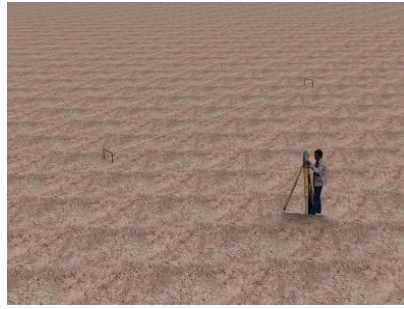
ขั้นตอนที่ 2 หาดำแหน่ง และวางแนวของโครงสร้างในสนาม
