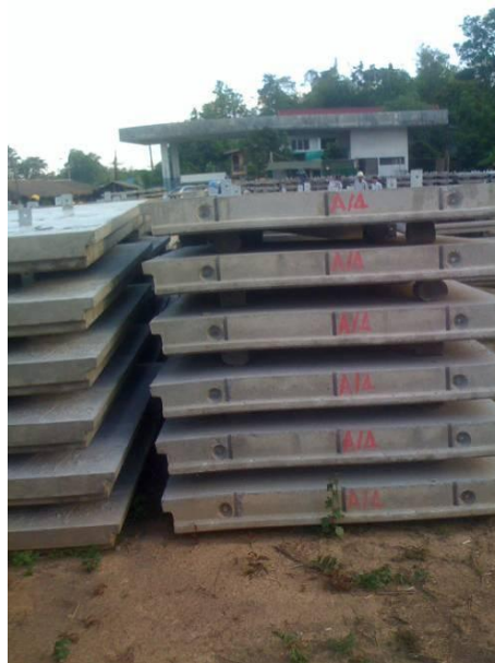
รูปที่ 4.14 การจัดเรียงแผ่นคอนกรีตพร้อมใช้งาน
