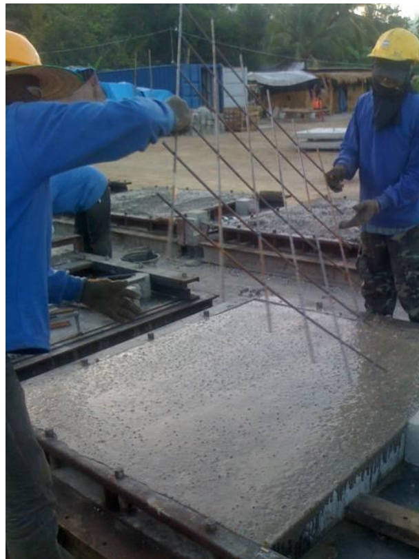
รูปที่ 4.8 การวางแผงเหล็กตะแกรงเหล็กเสริม
