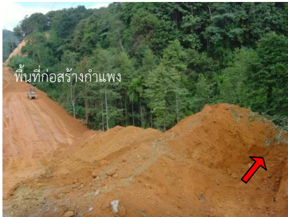
รูปที่ 5.17 การจัดการระบายน้ำก่อนเข้าพื้นที่ก่อสร้าง
