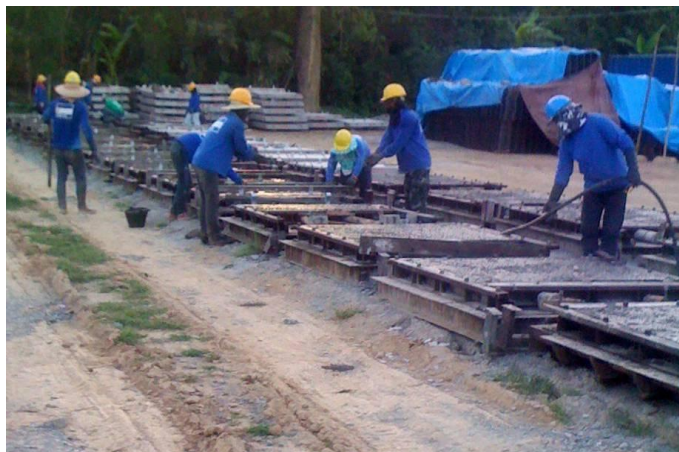
รูปที่ 4.6 การใช้เครื่องสั่นสะเทือนคอนกรีต
