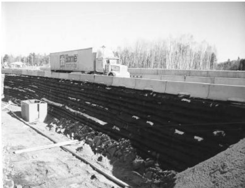
รูปที่ 2.4 MSE Wall สำหรับโครงสร้างค้ำยันชั่วคราวในการก่อสร้างคันทาง (FHWA, 2009)
