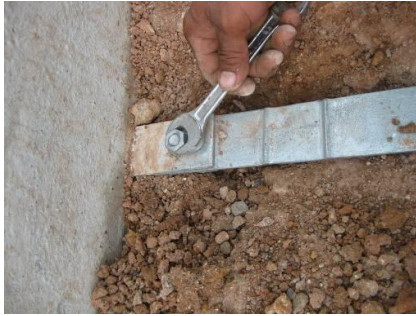
ติดตั้งวัสดุเสริมแรงประเภท Metallic Strip
