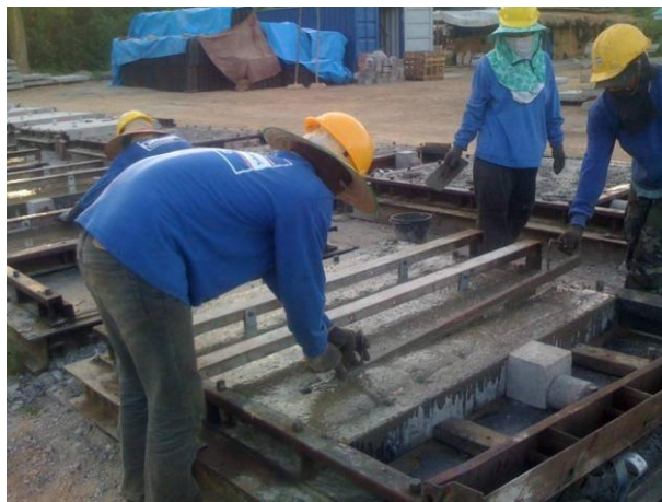
รูปที่ 4.10 การจัดวางตะแกรงเหล็กเสริม
