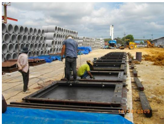
รูปที่ 4.4 การเตรียมและทำความสะอาดแบบเหล็ก
