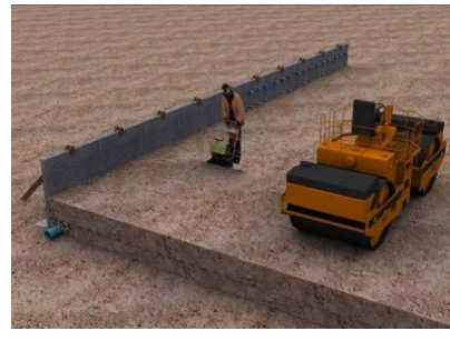
ขั้นตอนที่ 9 ลงวัสดุดินถมเสริมแรง แต่ละชั้นหนาน้อย 150 มิลลิเมตร ทำการบดอัดด้วยเครื่องจักร
