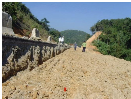
รูปที่ 5.12 การสำรวจเพื่อวางแนวขุดตัดดินเชิงลาด
