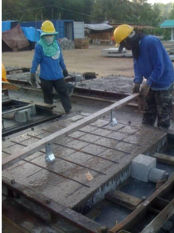
รูปที่ 4.9 การติดตั้งสมอยี่ดรั้ง
