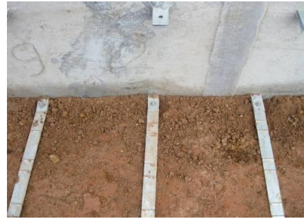
ติดตั้งวัสดุเสริมแรงประเภท Metallic Strip
