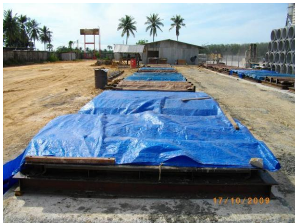
รูปที่ 4.12 การบ่มคอนกรีตเมื่อคอนกรีตเริ่มแข็งตัว
