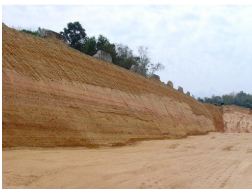
รูปที่ 5.16 การขุดปาดผนังด้าน Back Slope MSE Wall ให้เรียบก่อนปูวัสดุ Geotextile
