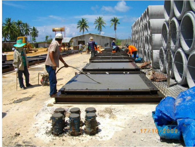
รูปที่ 4.7 การเก็บตัวอย่างคอนกรีต
