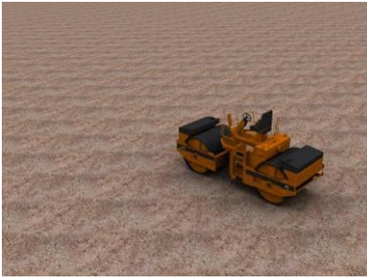
ขั้นตอนที่ 1 ปรับแต่งสภาพพื้นที่ เช่น ถมดินและบดอัดดินฐานราก
