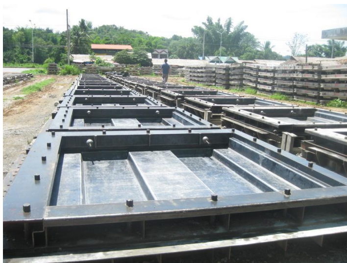
รูปที่ 4.1 แบบหล่อเหล็กถูกเตรียมไว้สำหรับการหล่อ Concrete Panel
