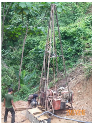
ข) เครื่องมือเจาะหลุมทดสอบแบบ Wash Boring และแบบ Rotary
